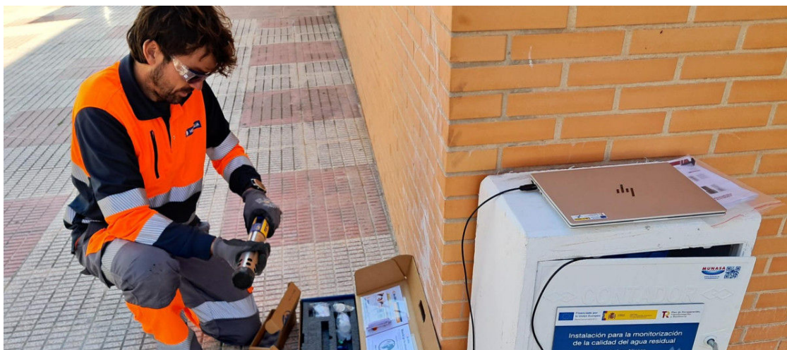
Modernización de la red hídrica de Castalla (Alicante)Veolia
